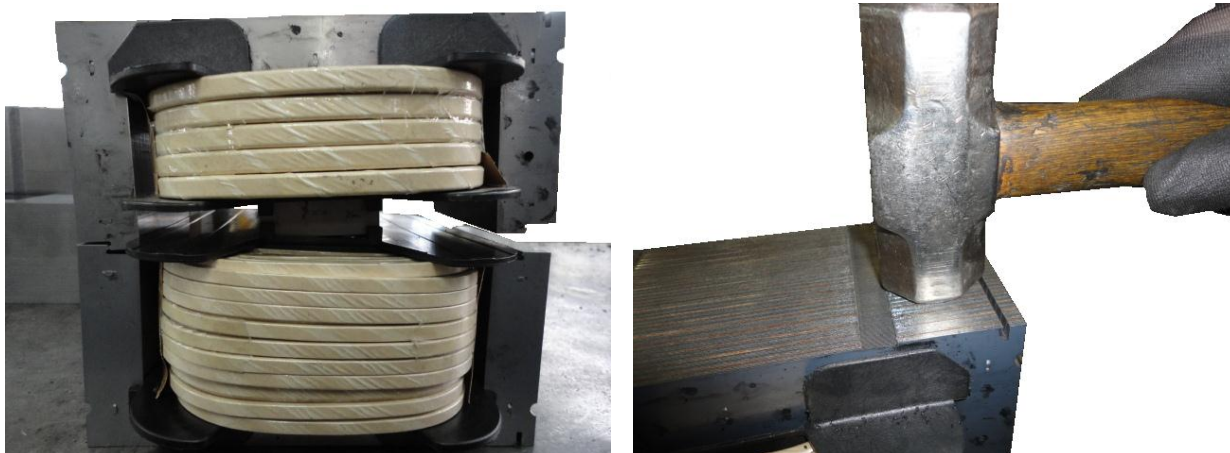
Figura 8 - Procedimento para fechamento do transformador
